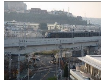
連続立体交差事業
