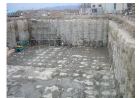
改良体出来形
