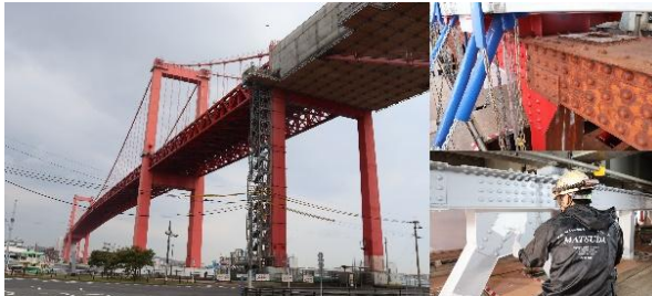
ダンジオーラE下塗を用いた橋梁補修工事の様子
