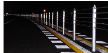
設置状況(夜間)
