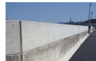
コンクリート防潮壁
