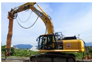
施工機械全景
