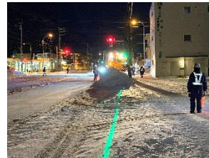
ローラー除雪車に設置
