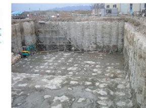
改良体出来形
