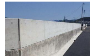
コンクリート防潮壁
