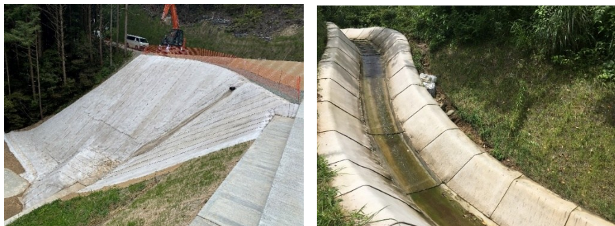
図一 5 施工事例（法面保護、水路ライニング）
