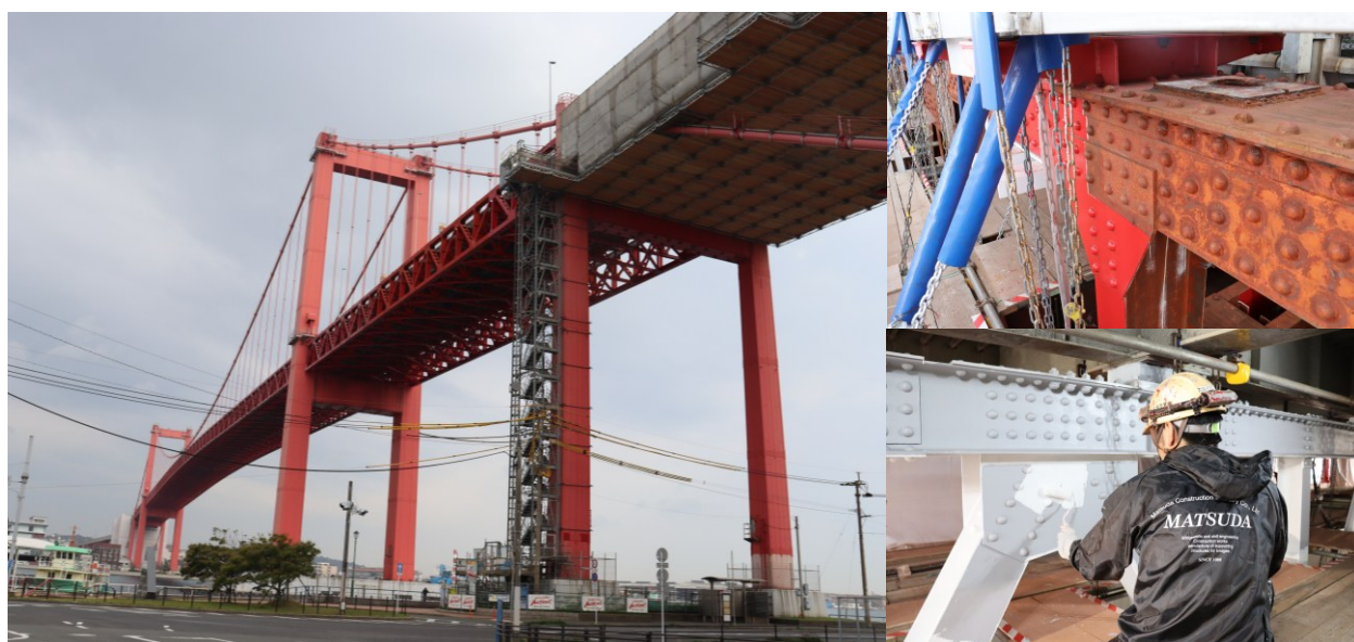
図-2 デンジオーラ E 下塗適用事例 橋梁補修工事の様子
