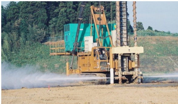
写真一 高压喷射状况
