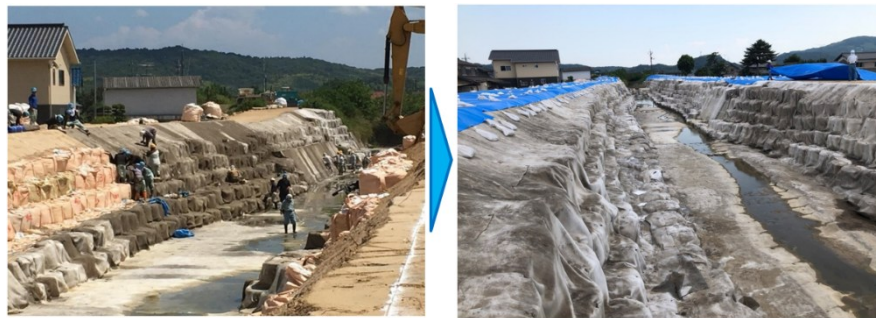
図一 4 施工事例（災害復旧）
