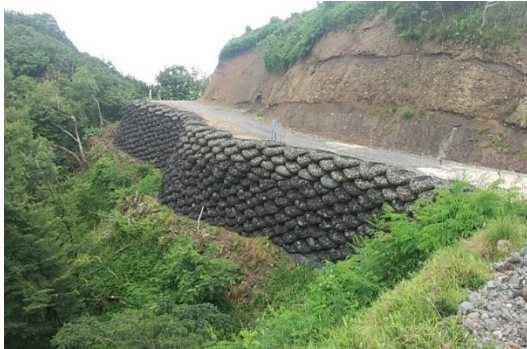
写真一 工所用道路
