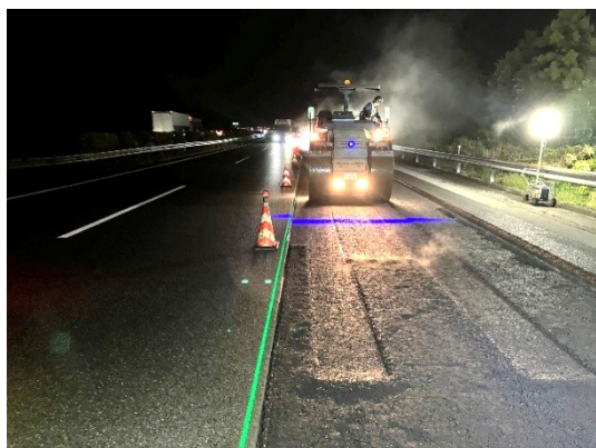
アスファルトフィニッシャーに設置（舗装工）
