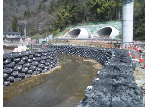
写真二 仮設護岸工
