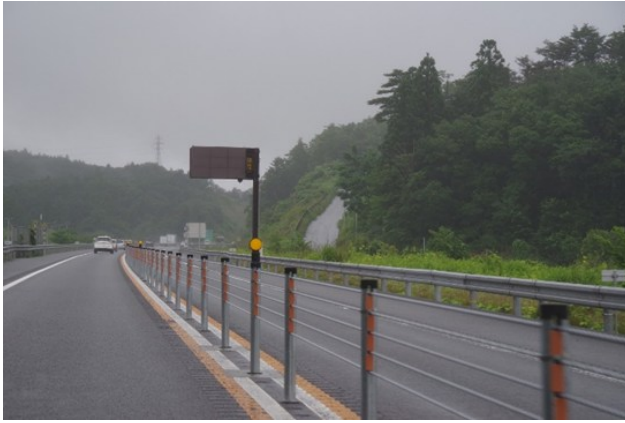
写真一 1 昼間取付状態
