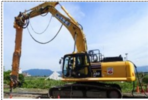
写真一 施工機全景
