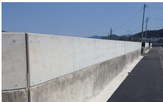
写真一 1 コンクリート防潮壁
