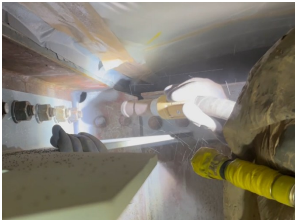
写真ー1 ショットピーニング施工状況
