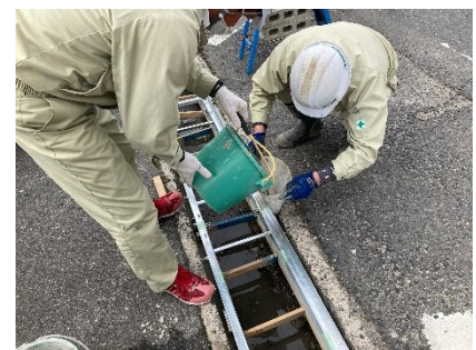
写真四 施工途中
