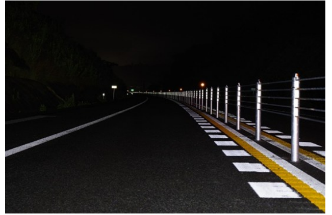
写真一 2 夜間取付状態
