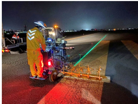
小型自動式施工機に設置（区画線工）
