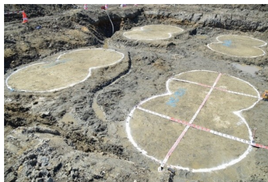
写真一 3 SDM-Fit 改良体
