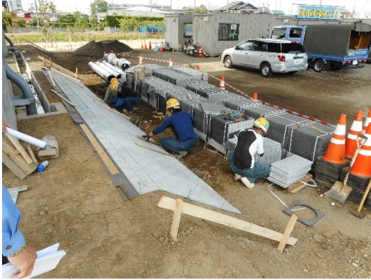
写真一 1 施工中
