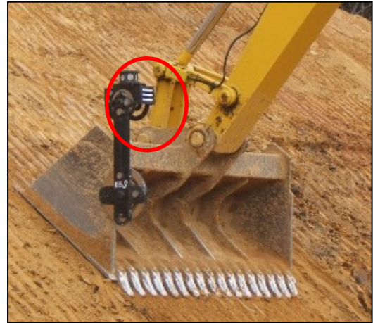
写真② バケットの角度は勾配目視装置で確認
