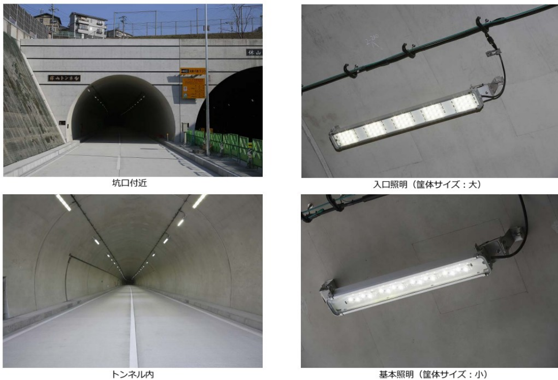
写真一 2 施工事例
