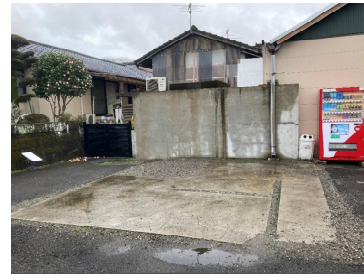
施工前の駐車場
