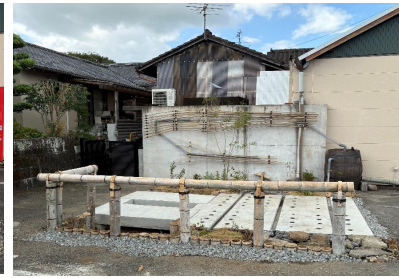
施工後の駐車場
