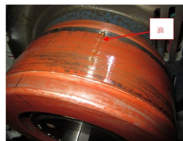
写真2 モーターローター油付着状況
