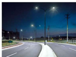
LED照明※ (消費電力約56%削減)
