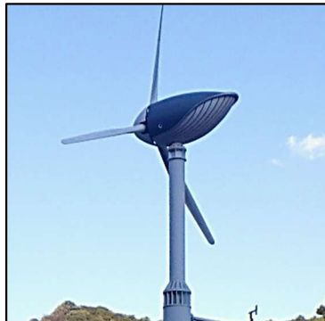
風力発電整備事例 (国道42号(和歌山県太地町))
