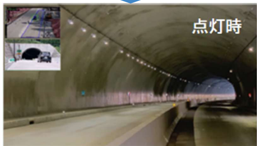
センサー照明設置事例
