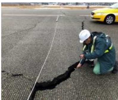
空港基本施設(滑走路等)の調査
