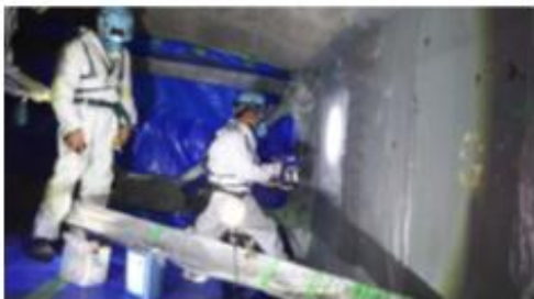
剥離剤塗布状況
