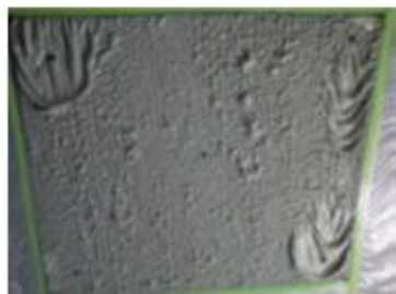
剥離剤塗布後
