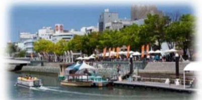
親水護岸の利用 (新町川/徳島市)
