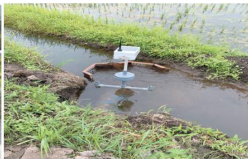
②水管理システム 水田の水位等をいつでも確認し、遠隔で管理できるシステム
