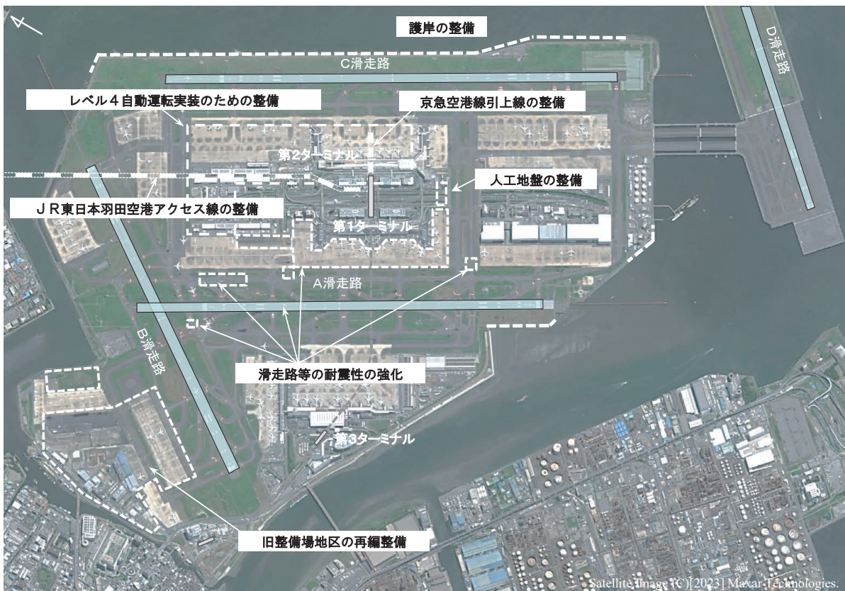
図表4-2 羽田空港の整備
