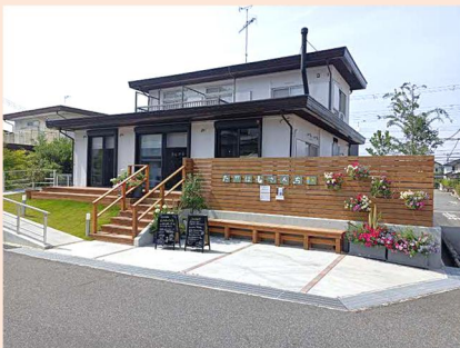
戸建住宅をリノベーションしたコミュニティ拠点
