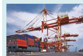
ガントリークレーン
