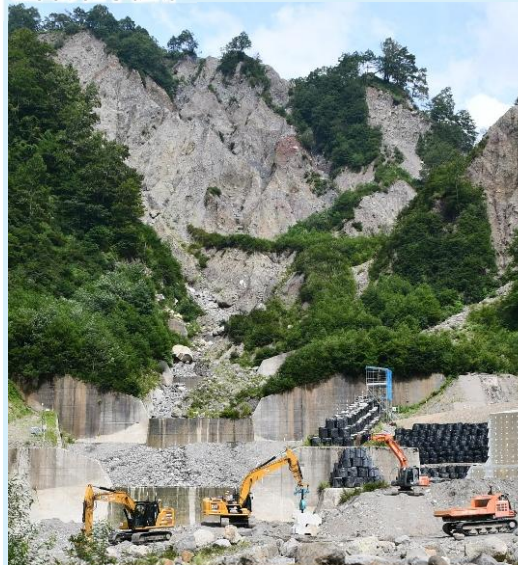
掘削、土砂運搬、ブロック据付
