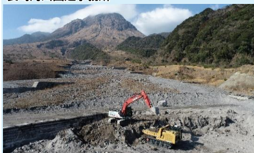
除石、土砂運搬(自動走行)
