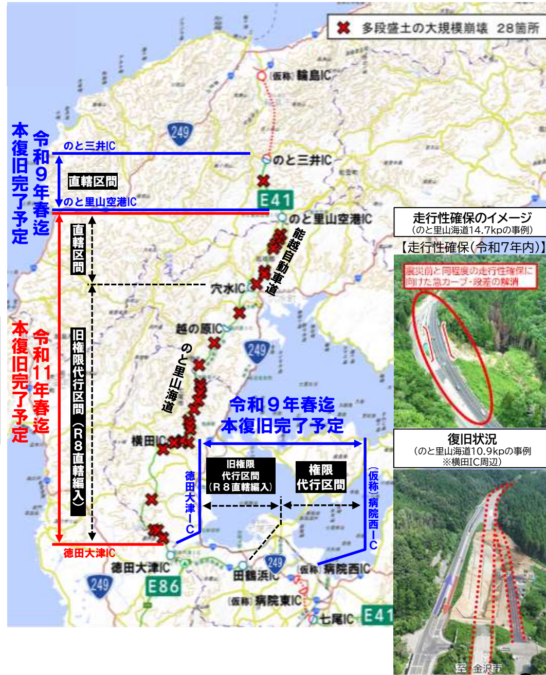
能越自動車道等の本復旧の見通し
