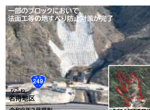
⑥国道249号沿岸部 地すべり対策（石川県輪島市）
