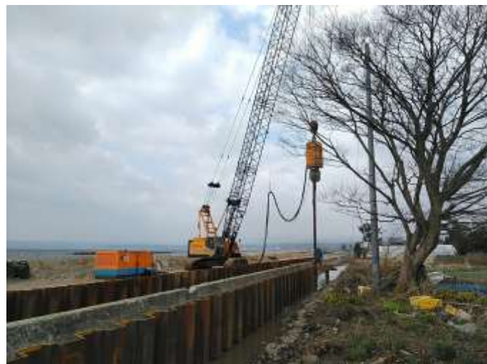
本体復旧状況（仮設工）
