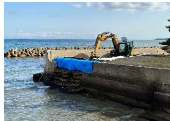
袋詰玉石、大型土のう敷設完了
