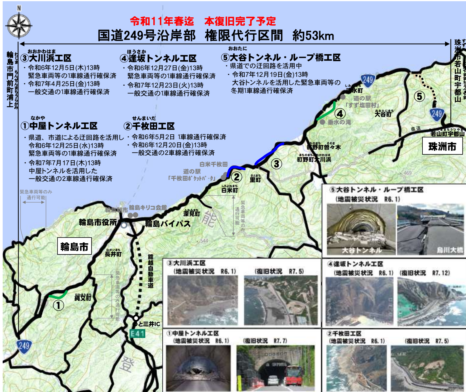
国道249号(沿岸部)本復旧の見通し
