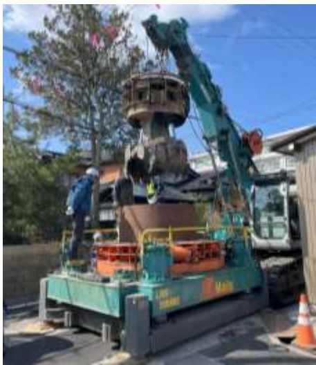
立坑設置の施工状況
