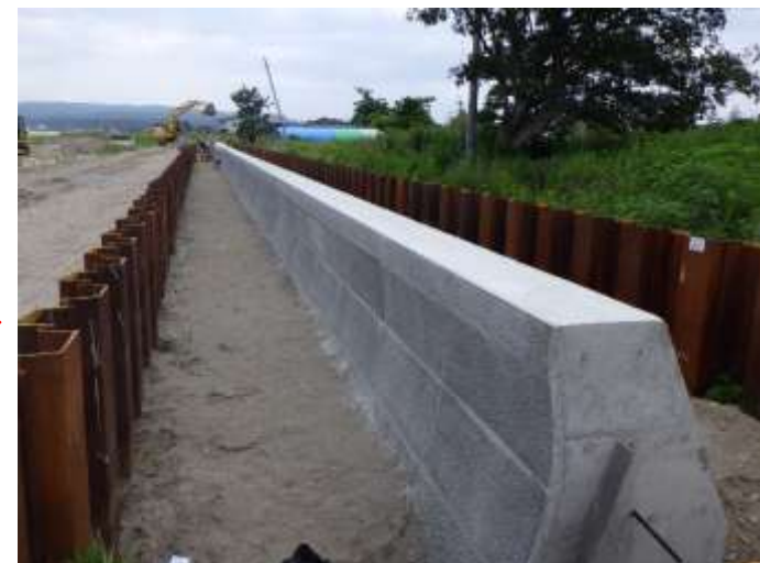
本復旧状況（護岸復旧）
