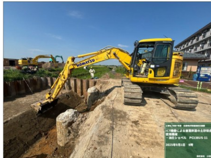
（ICT建機による崩壊斜面の土砂撤去）
