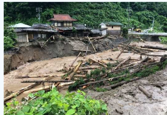
土石流の状況（岐阜県高山市）
