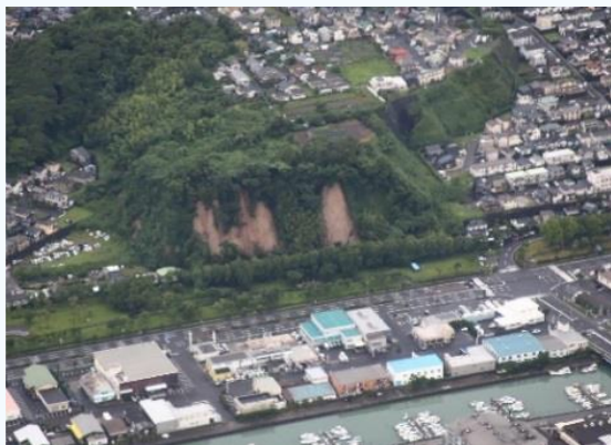
土砂災害の状況（鹿児島市）
