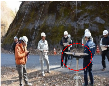
(スターリンクの設置)
