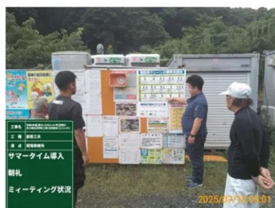
写真1 作業前のKYミーティング
