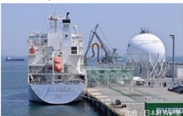
港湾（受入環境整備）
