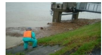
目視による内外水位の確認
