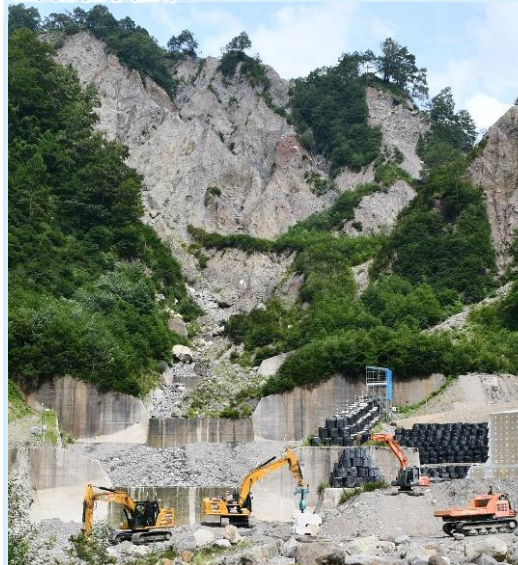
掘削、土砂運搬、ブロック据付
