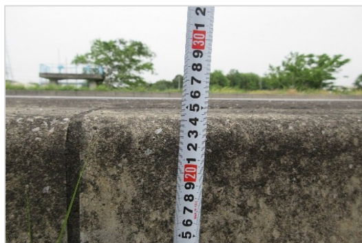
写真5—1 中央分離帯縁石高さ
