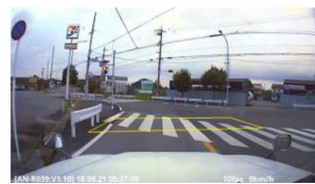
ドライブレコーダーで取得した 画像による区画線の摩耗判定
