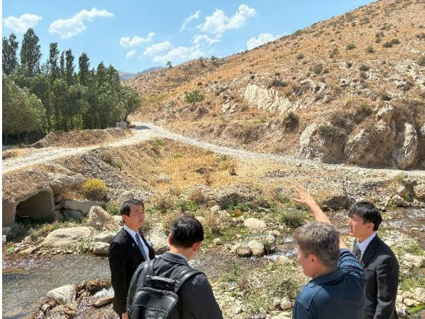
視察（トンネル坑口予定地付近）の様子
