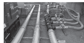
防衛大臣賞 RAKUYU-Z工法 （不断水替工法） 京環メンテナンス株式会社
