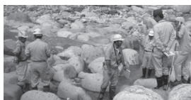
国土交通大臣賞 太田切川の常水路工（魚道）施工の スタンダード化 飯島いものつくろう会
