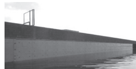
農林水産大臣賞 FRGカバー工法（埋設型枠）による漁港 等水産基盤施設の補修・防食技術 株式会社タイター
