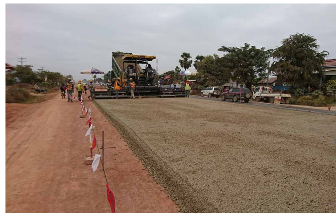
交差点のコンクリート舗装 (Sta.237km)。
