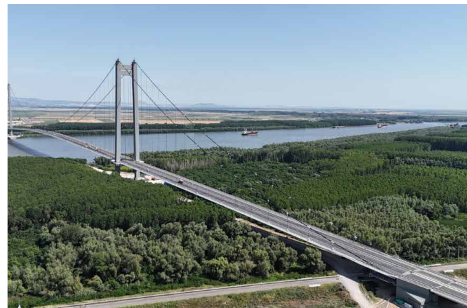
吊橋部の完成写真。
