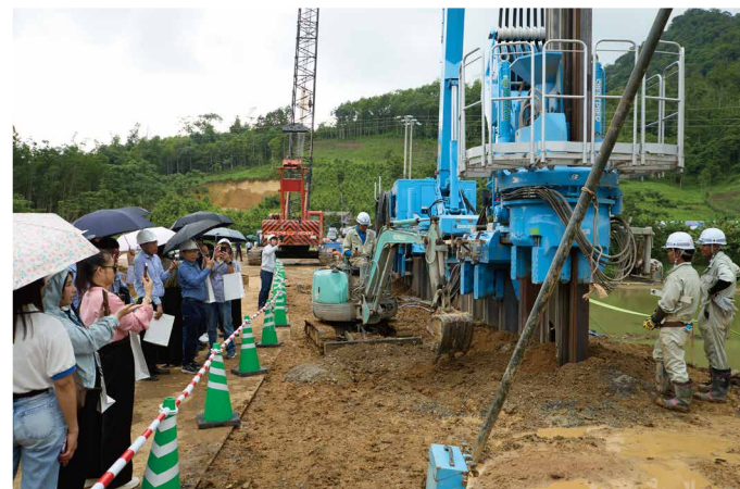
鋼矢板圧入作業状況の現場見学会を開催しました。遠方にもかかわらず、多くの方がお越しください、ベトナム初の機械設備と工法に興味を持っていただいた。
