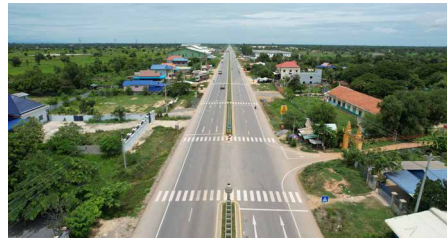
4車線化された ルーラルエリア (Sta.195km)。
