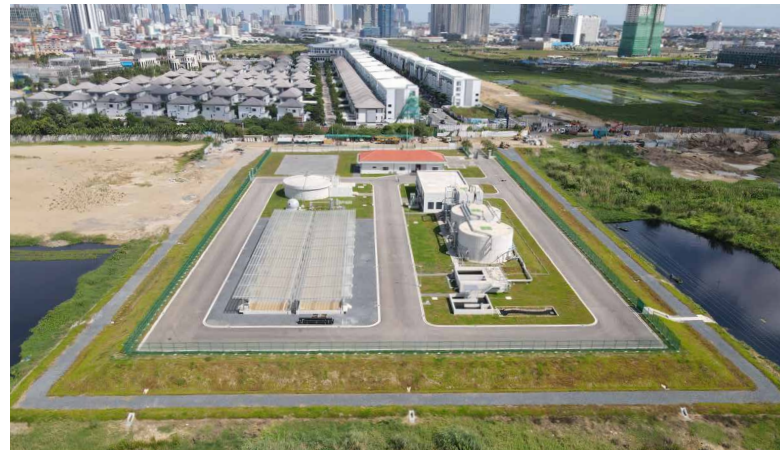
開発が進む都市環境を支えるプノンペン初の下水処理場。
