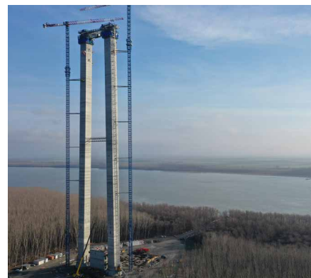
主塔施工遠景。
