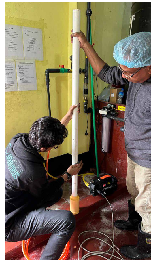
浄水設備の配管や処理塔の状態を確認し、安定した運転を維持するため、現地で点検・メンテナンスを実施している。
