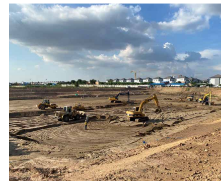
夜間の通行量が少ない時間帯に堆積物を運搬し、昼間に敷均し転圧による埋戻し(208,000m3)作業を実施。
