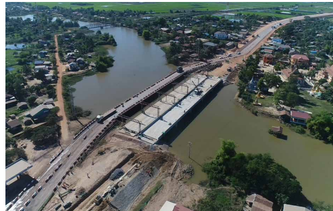
乾期のNo.59橋梁：下部工の施工状況 (Sta.220km)。
