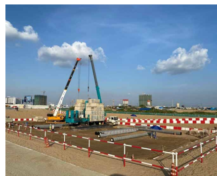
ポンプ棟の杭圧入施工(PHCパイプφ400mm)。
