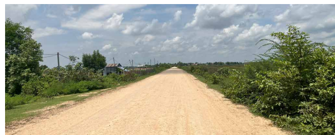
カンボジアで現場土を用いて整備された農道。
