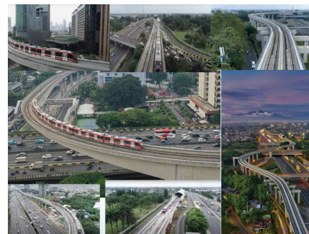
全長44.5kmの駅舎を含む一部の高架橋の完成時の風景(計10本の長大橋以外の箇所は標準スパン30mのプレキャストU・字型の桁を設置)。
