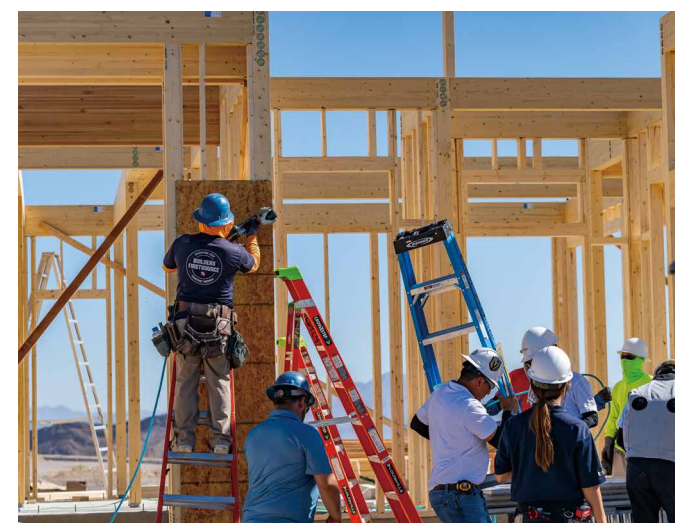
躯体工事。 当社独自の「S-MJ構法」を米国でも施工する為、現地での施工訓練だけではなく、英語版の施工マニュアル・動画を作成して効果的に訴求している。
