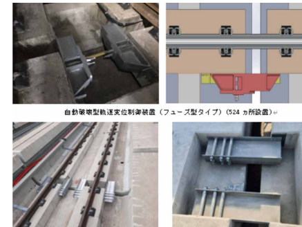
世界初のFuse型・Unfused型変位ストッパー(CD)を開発し、大地震時は構造物保護を優先する変位制御システムを実現。
