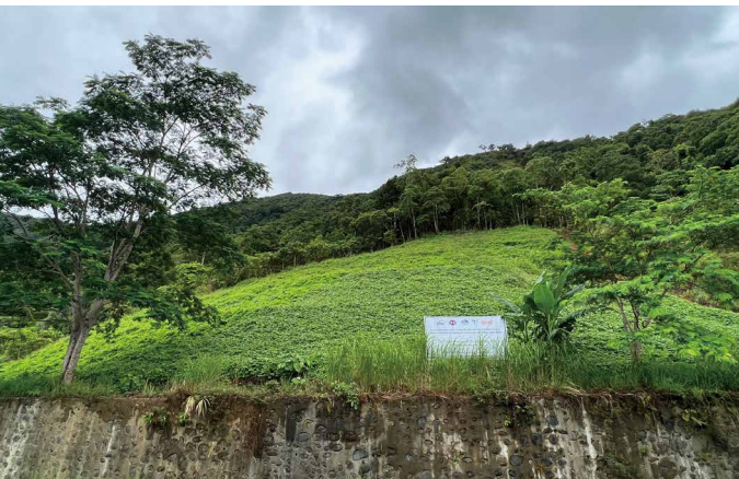
施工後3ヶ月経過。装着した種子が発芽・生育し、順調に緑化が推移している。
