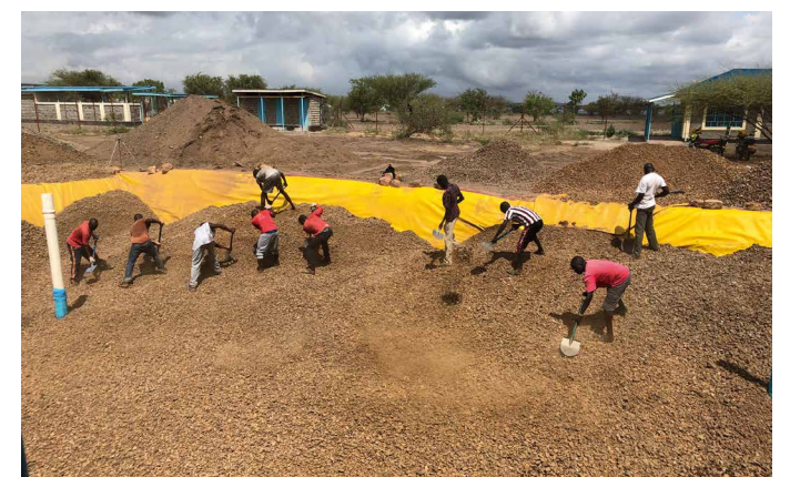
取水のための管を立て、上部を埋め戻して完成。
