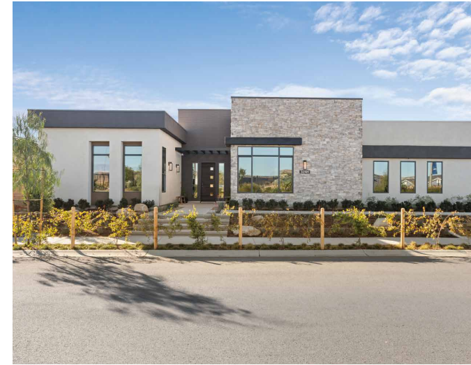
建物名Yuri。 フラット屋根が特徴のモダンな建物。素材や大きさの異なるボックスの組み合わせが印象的な外観。
