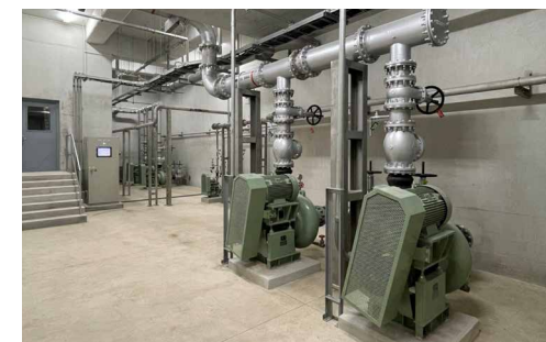
主ポンプ棟内の圧送ポンプ設置。
