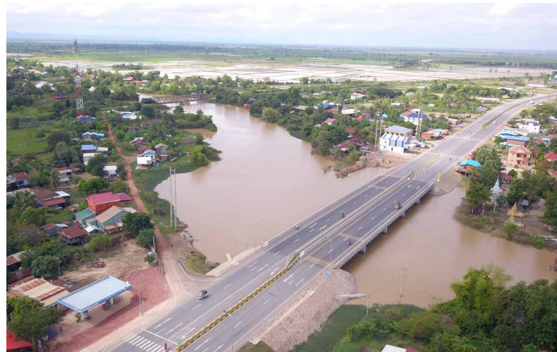
No.59橋梁の竣工 (Sta.220km)。
