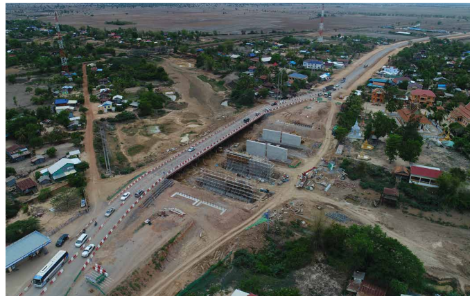
プルサット州とバタンバン州の州境の全景 (Sta.222km)。
