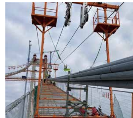
ケーブル架設中。
