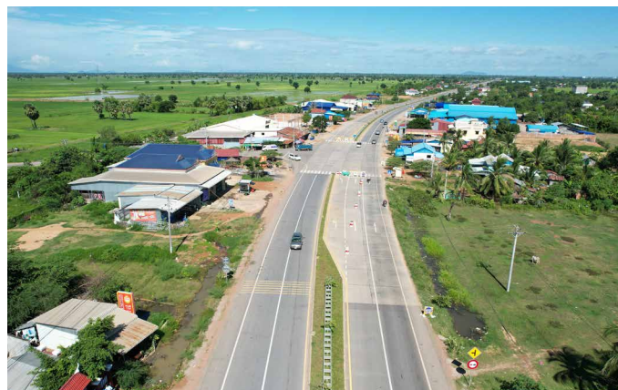
雨期のNo.59橋梁：上部工のPC桁架設状況 (Sta.220km)。
