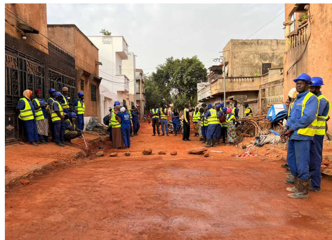
マリにおけるILOと連携したコミュニティ道路整備。
