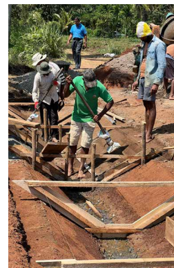
スリランカにおける灌漑用水路整備。
