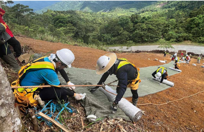
侵食防止用マット施工状況。
