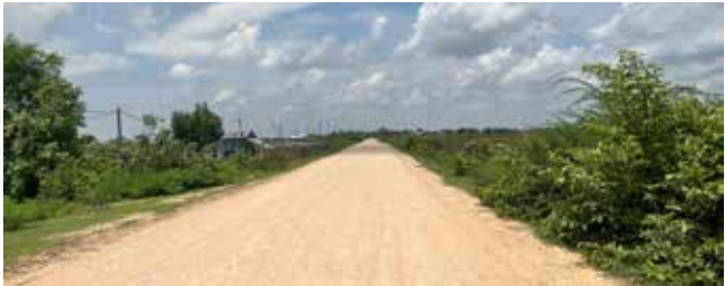
カンボジアで現場土を用いて整備された農道。
