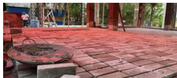
JICAの「Bangladesh金融包摂強化プロジェクト」において天災害に脆弱な地域で試験的に家屋建設に使用。
