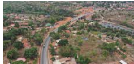
スンバ橋取付道路の全景。 橋梁の架け替えと併せて延長 763mの取付道路を整備し、 線形改良により走行性の向上 と円滑な交通の確保を実現。 写真手前がボケ方面、奥が首 都コナクリ方面。
