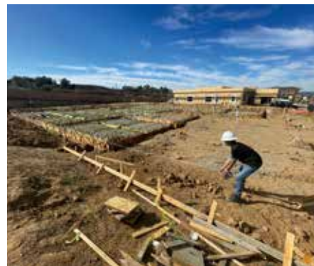
基礎工事。日々の施工管理と社内検査で品質確保。
