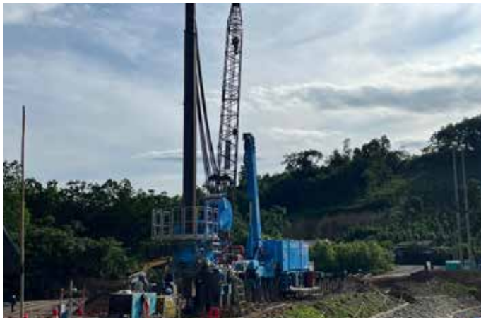
サイレントパイラーにより、岩盤層を含む硬質地盤に対してハット形鋼矢板を連続的に圧入し、水密性の高い遮水壁を構築。
