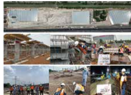
河川沿いの軟弱地盤にプレキャスト人工地盤を採用し、12haの車両基地を約4m嵩上げ施工、工期を短縮。
