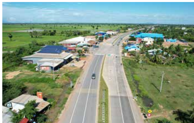
交差点のコンクリート舗装 (Sta.237km)。
