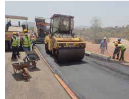
ギニア初となるポリマー改質アスファルトの舗設状況。 大型車混入率20%超の重交通条件下において耐流動性を 向上。現地の連続式プラントを活用した高品質な合材 製造を実現。
