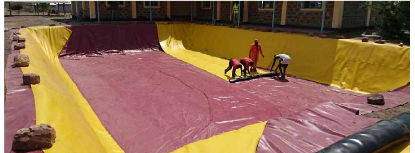
掘削し、シートを設置。
