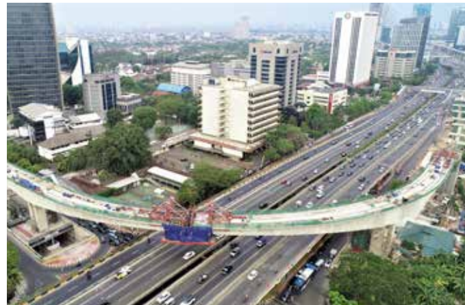
R=115m急曲線・148m世界最長級鉄道橋を片持張出工法で施工し、無事故で接合を達成。
