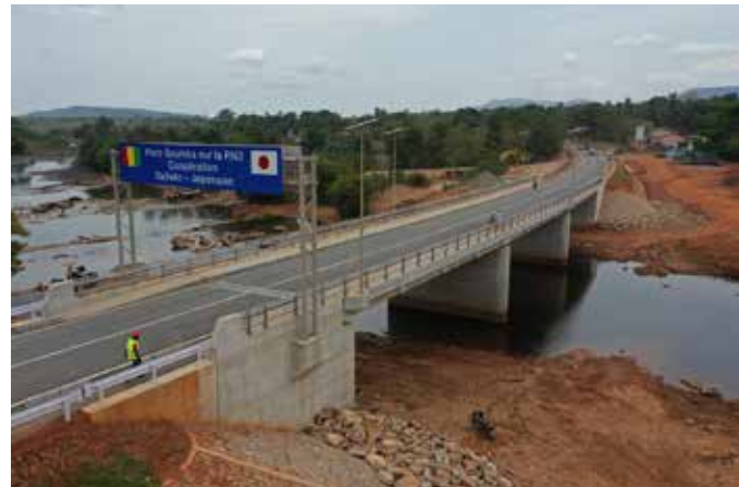
完成したスンバ橋の全景。 PCポストテンション方式スラブ桁および改質アスファルトを採用。 オーバーヘッド型の大型標識板により「日本のプロジェクト」であることを広く周知。
