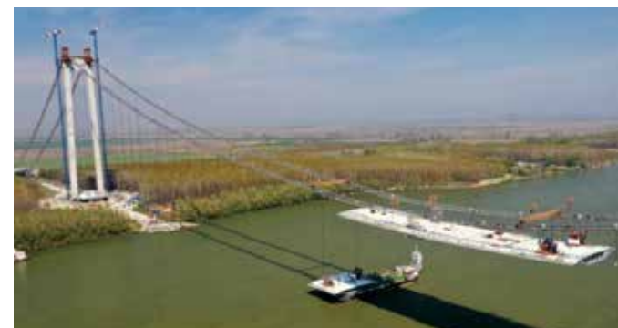
河川部は、ストランドジャッキによる直下吊りを実施。
