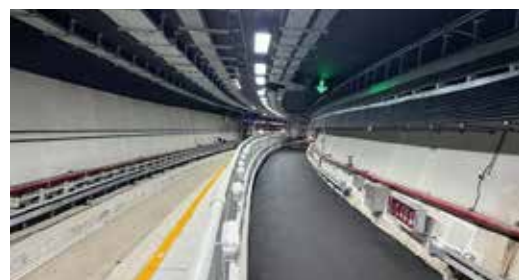
橋梁(西湾大橋)内部の写真。
