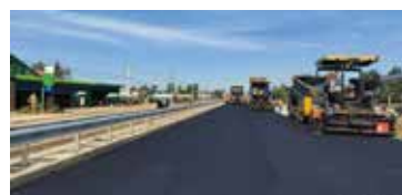
アスファルトフィニシャー3台並列による舗装 施工 (Sta.194km 右車線)
