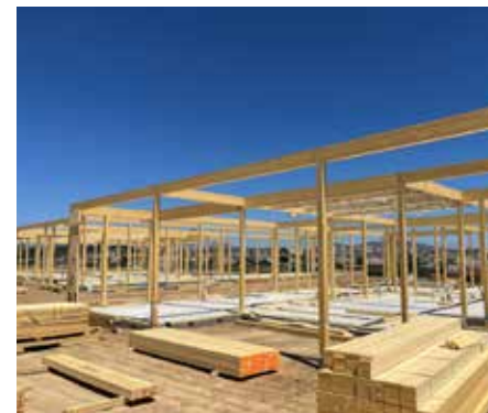
躯体工事。廃材を削減し現場調整を抑えるシステム。
