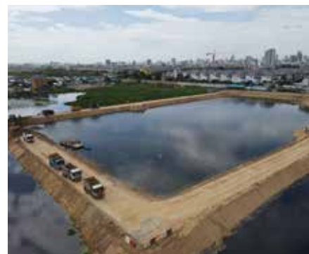
建設予定地の湖底に堆積しているヘドロ・有機物を除去するために盛土(約98,000m3)による仮締切を実施。
