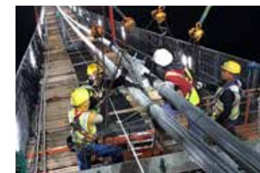
AS工法による主ケーブル架設。
