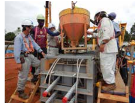
プレキャストPC桁（ポストテンション方式スラブ桁）の製 作状況。 本形式の採用により、桁高支間比約1/26（支間長 24.7m、桁高950mm）の低桁高構造を実現。
