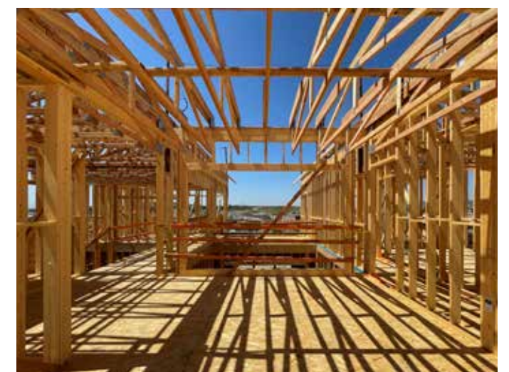
躯体工事。 高耐久・長寿命の建物を提供する為、柱・梁などの構造躯体(集成材)は日本の当社工場から出荷。現地2×4材と融合した建物となっている。
