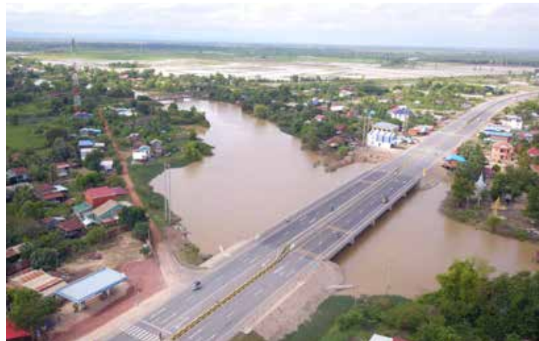
No.59橋梁の竣工 (Sta.220km)。
