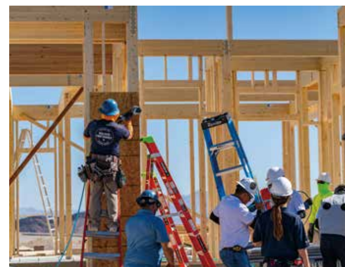
躯体工事。 当社独自の「S-MJ構法」を米国でも施工する為、現地での施工訓練だけでなく、英語版の施工マニュアル・動画を作成して効果的に訴求している。
