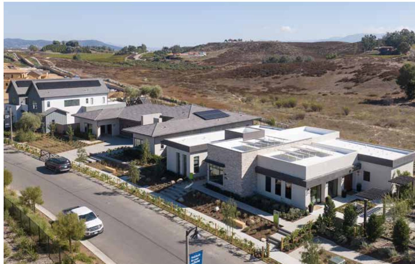
モデル棟3棟の全景。カリフォルニア州ロサンゼルス市中心部から車で約2時間のテムキュラに位置し、周囲には公園やトレイル、保護地区など自然豊かなコミュニティ。
