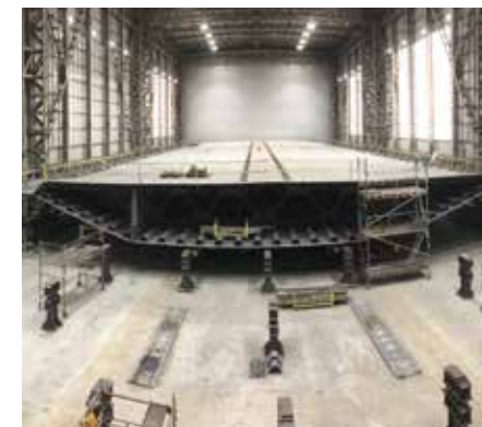
屋内での補剛桁仮組。
