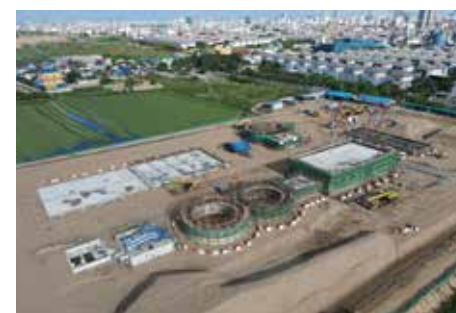
杭施工完了後、各施設の構築が開始される。
