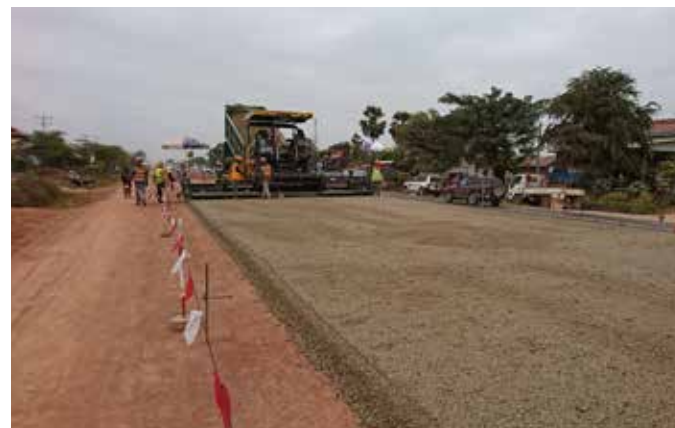
上層路盤の施工状況 (Sta.235km 左車線)。
