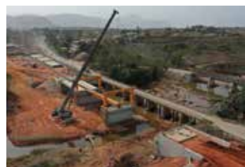
プレキャストPC 桁（ポストテン ション方式スラ ブ桁）の架設状 況。
