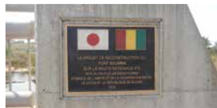
親柱に設置したプロジェクト 銘板。 日本とギニア両国の友好の証 として、日本の無償資金協力に よる建設を記念して設置。
