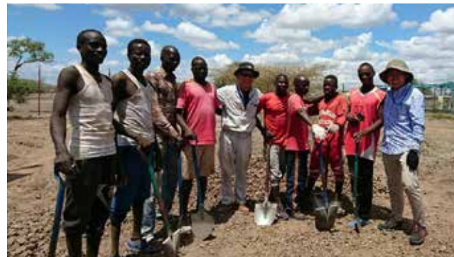
現地住民と協働で進める「ためとっと」の施工。
