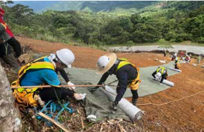
侵食防止用マット施工状況。
