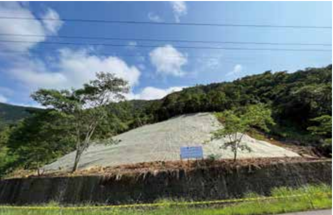
施工直後。DPWHの製品認定制度に基づき、試験施工を実施。
