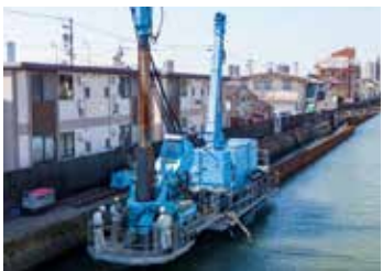
サイレントパイラー(硬質地盤対応型)にノンステージングシステムを併用した施工状況。
