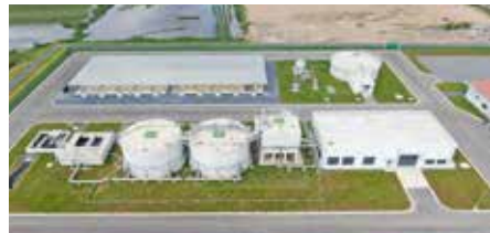
本邦技術であるPTF法による下水処理施設の全景。
