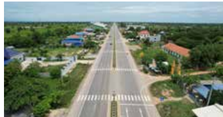
4車線化された ルーラルエリア (Sta.195km)。
