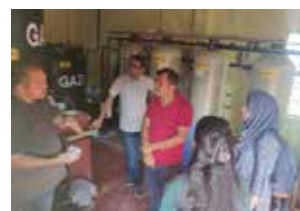
現地水質調査機関 (icddr,b) の浄水設備視察。
