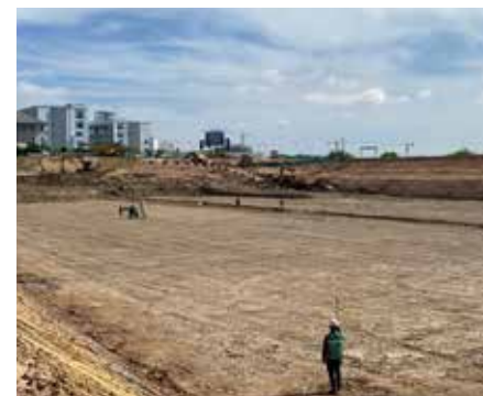
湖の堆積土を全て取り除きコンサルタントの立会いを実施。
