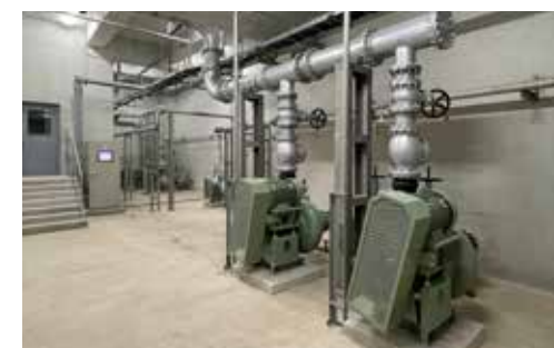
主ポンプ棟内の圧送ポンプ設置。
