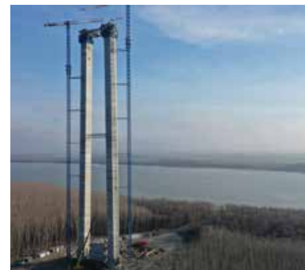
主塔施工遠景。
