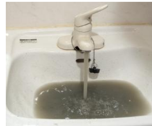
蛇口から井戸の濁り水が出ている状況
