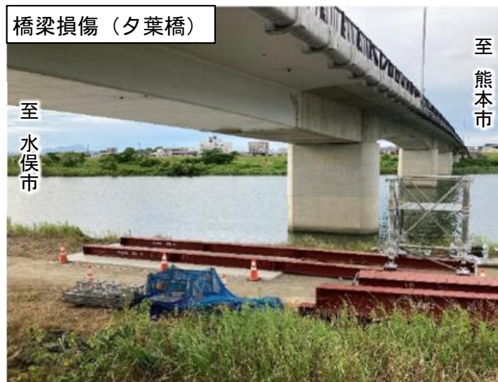
応急復旧 (仮設ベント設置)
