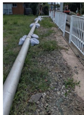
地上への仮設配管
