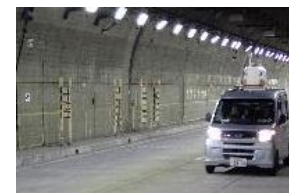
全方位画像を取得可能なカメラ及びレーザ等により覆工表面を計測
