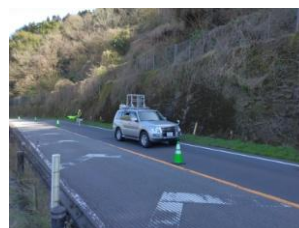
MMS※1を活用した 斜面・のり面点検
