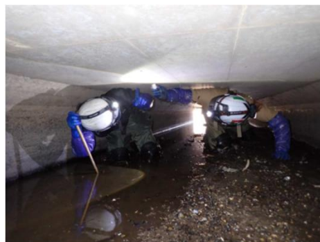
進入困難箇所の近接目視
