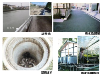
雨水貯留浸透施設の例
