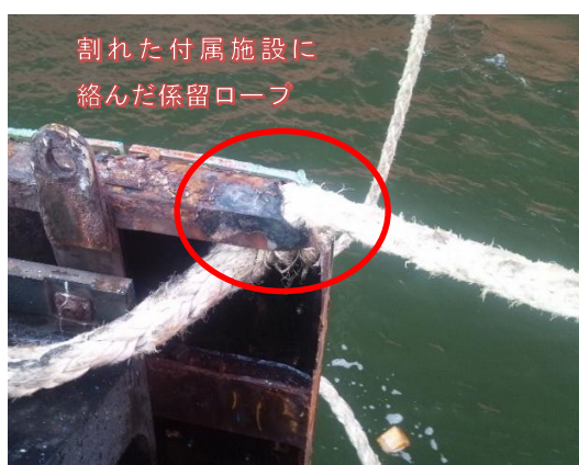
写真9：付属施設に絡んだ係留ロープ
