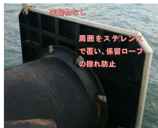
写真10：係留ロープが絡みにくい対策
