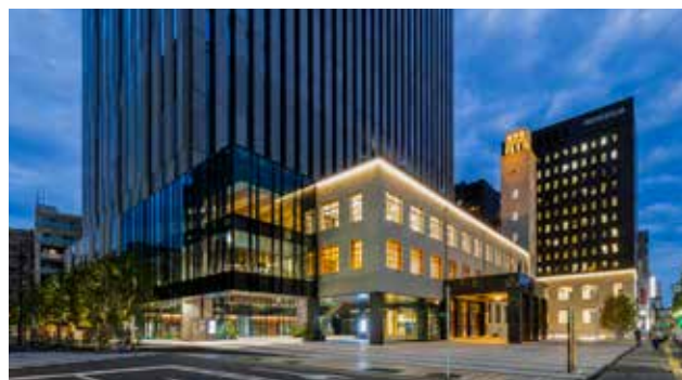
復元棟のライトアップや広場の足元を照らす動きのある演出照明など、夜間のスカイライン形成や照明による、川崎市の情報発信など、新たな夜の「まちの顔」となることを目指した照明計画。
