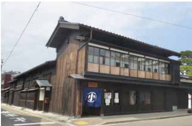
旧小澤家住宅。丁字型町屋の例。建物手前側が横屋根で奥側が縦屋根となっている建物形態となっている。
