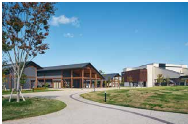
地域住人同士が関われる場所として、集会所と連続した大きな軒下空間を設け（写真中央）、その先に駅前広場と駅舎が広がるよう配置の工夫を行なった。
