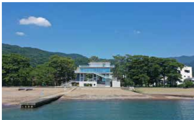
当地区は、伊豆半島の西側中腹に位置する扇状地の温泉街で、眼前に駿河湾を望む。“海と共に生きる”観光防災まちづくりをきっかけ、中心の地域のシンボルである松原公園を再整備し、観光と防災を統合した津波避難複合施設テラッセオレンジトイを建設した。
