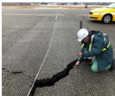
空港基本施設(滑走路等)の調査
