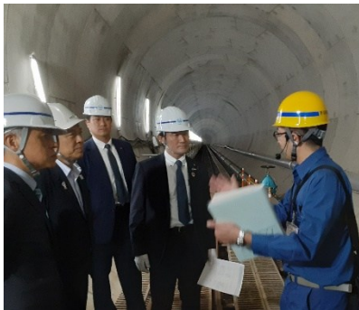
名古屋中央雨水調整池の整備状況を視察する井林大臣
