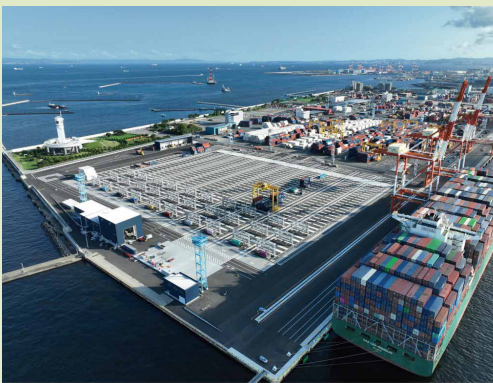
横浜港本牧ふ頭 コンテナターミナル【神奈川県】
