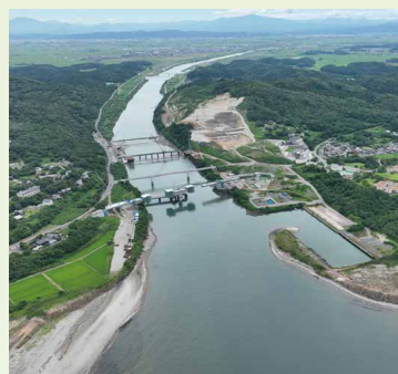
大河津分水路【新潟県】
