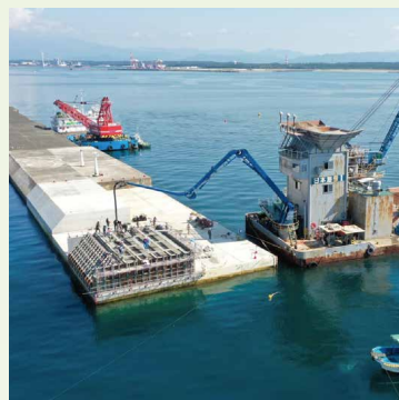
酒田港第二北防波堤【山形県】
