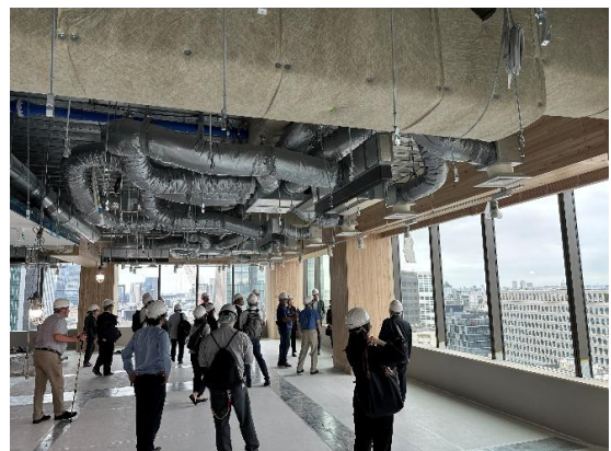
竣工時に国内で最大規模の木造となる 事務所ビルの建設現場の視察
