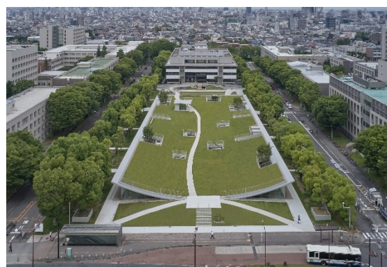
涵養機能を持たせた大規模屋上緑化の例 （東海国立大学機構 Common Nexus（大学施設））
