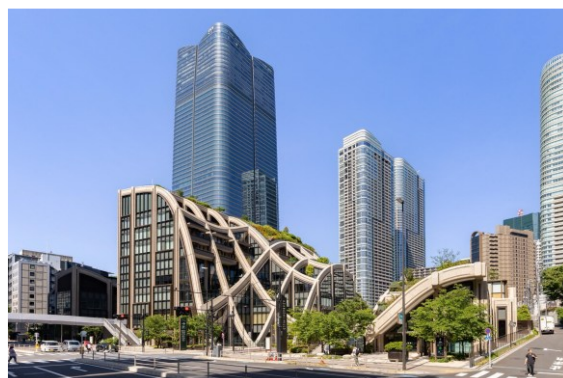
複雑曲面を有する大規模屋上緑化の例 （麻布台ヒルズ（大型商業施設））
