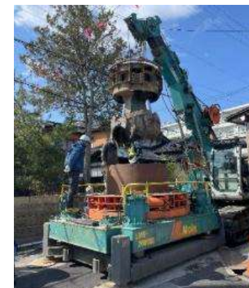
立坑設置の施工状況
