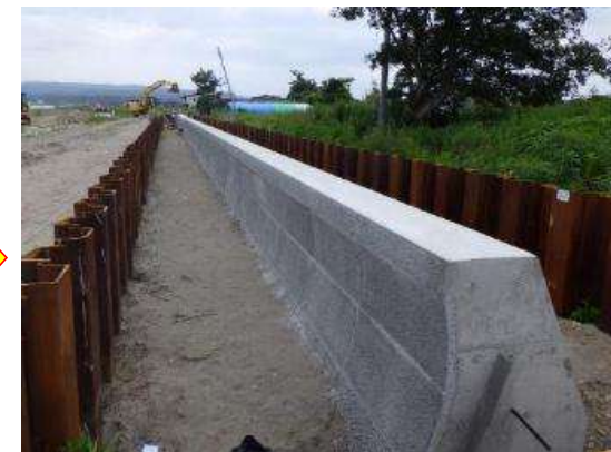
本復旧状況（護岸復旧）
