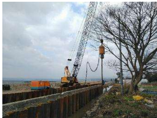
本体復旧状況（仮設工）
