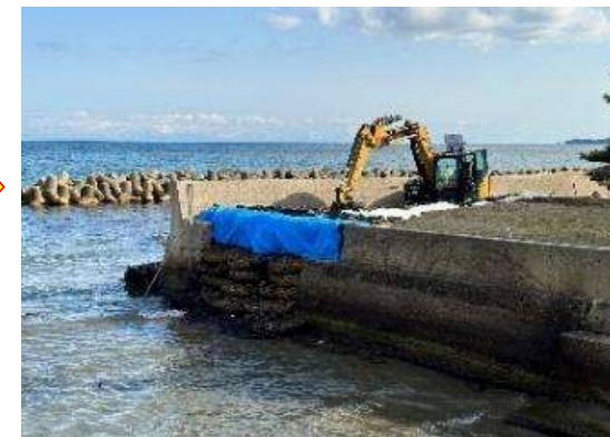
袋詰玉石、大型土のう敷設完了
