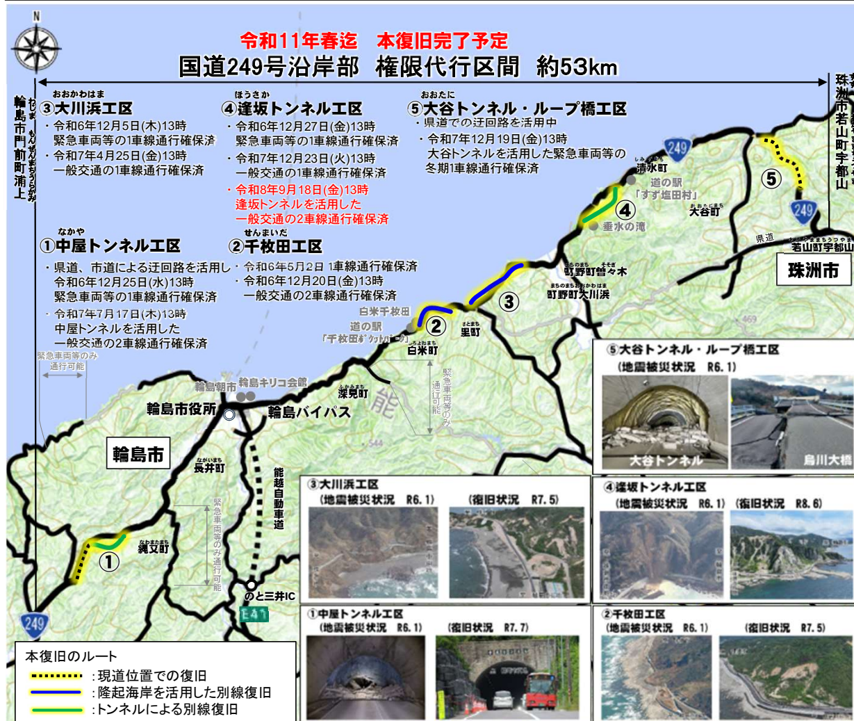
国道249号(沿岸部)本復旧の見通し
