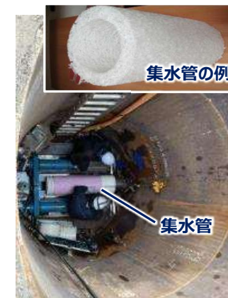
立坑底部からの 集水管設置の施工状況
