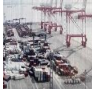
⑥神戸港六甲アイランドにおける浸水被害 (兵庫県神戸市)
