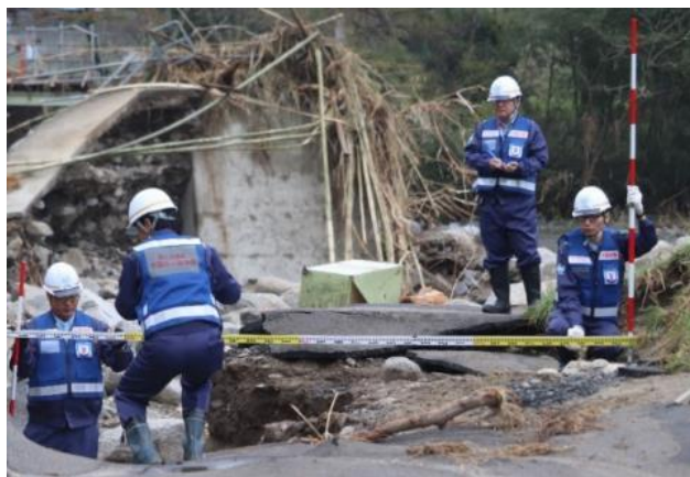
10月22日 茨城県日立市における 道路施設の被災状況調査【中国地整・道路班】
