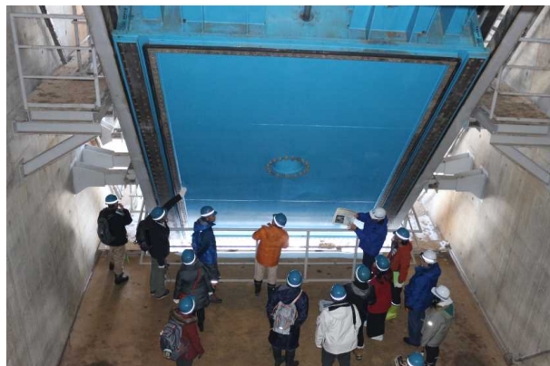
堤体内見学(奈良俣ダム：表面水ゲート)
