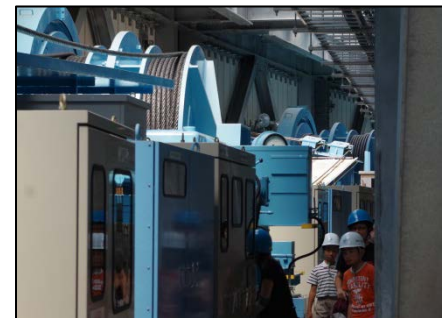
非常用放流設備操作室
