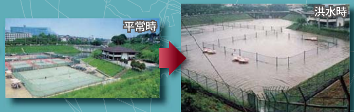
平常時にはテニスコートとして使われている雨水貯留施設 (日本、鶴見川流域)
