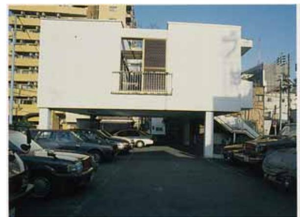
洪水時に被害がないようピロティ構造を採用
