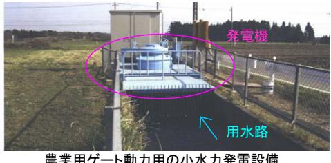
農業用ゲート動力用の小水力発電設備
