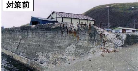
コンクリートの劣化等老朽化が進んだ護岸
