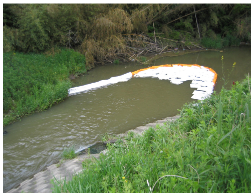
写真 9-3 油流出の際の対応（オイルフェンス）
