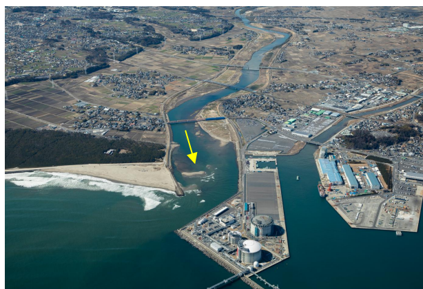
河口から 0.0km (東海村・日立市)
