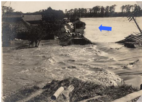
久慈川本川堤防決壊（左岸） （日立市留）
