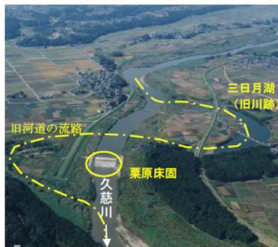
写真4-8 栗原・門部捷水路付近（2002 年 12 月撮影）
