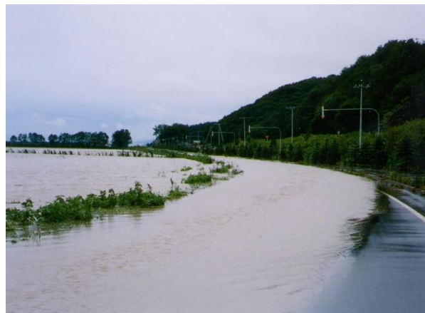
道道米原田浦線浸水状況
