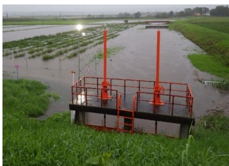
汐見樋門付近出水状況
