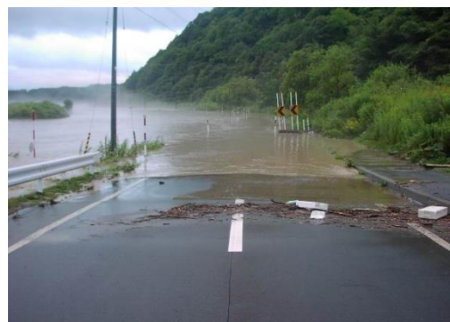
町道穂別豊田線浸水状況
