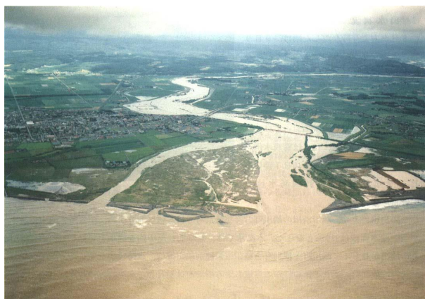
鵠川河口出水状況
