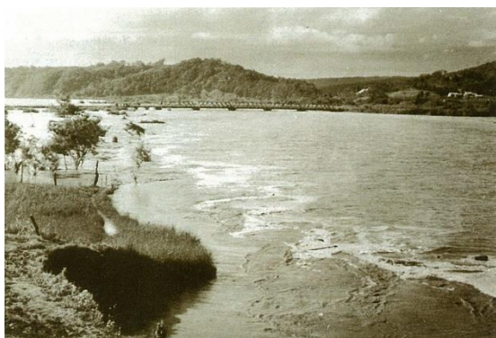
米原地区春日橋取付道路冠水状況
