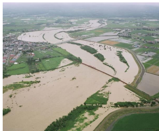
むかわ町市街部出水状況
