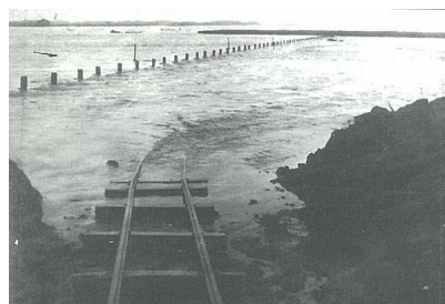
富内線浸水状況
