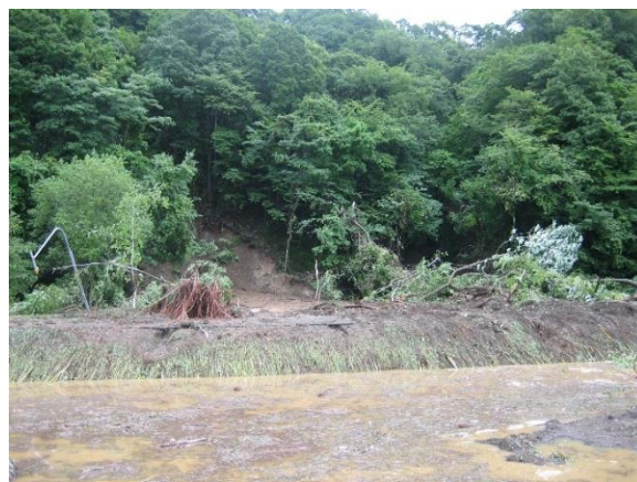
有明築堤道道合流部出水状況
