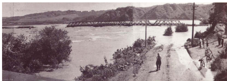
生鼈橋(現旭生橋)
