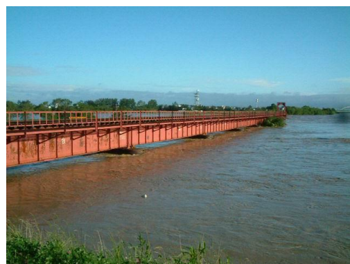
鵒川鉄道橋出水状況
