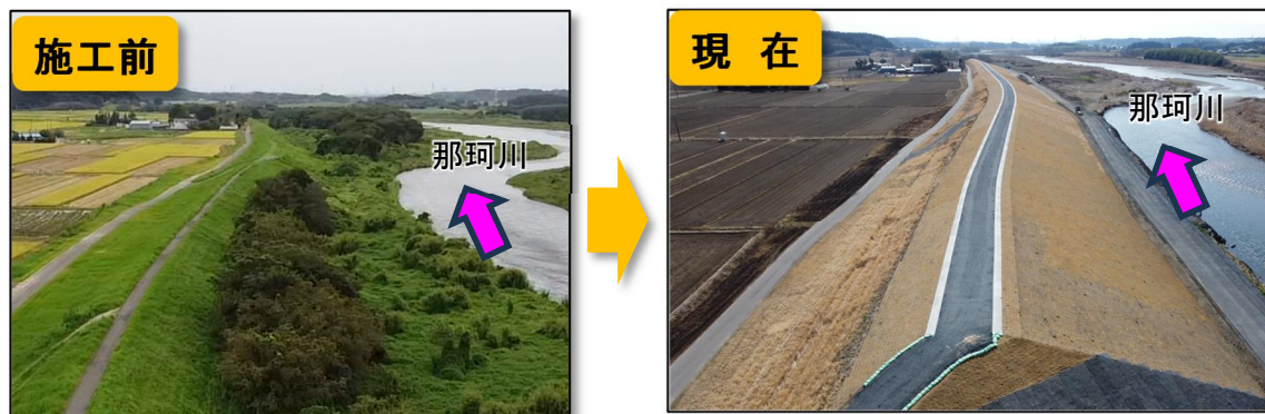
図 4-14 那珂川左岸 32k 大場遊水地囲ぎよう堤整備状況
