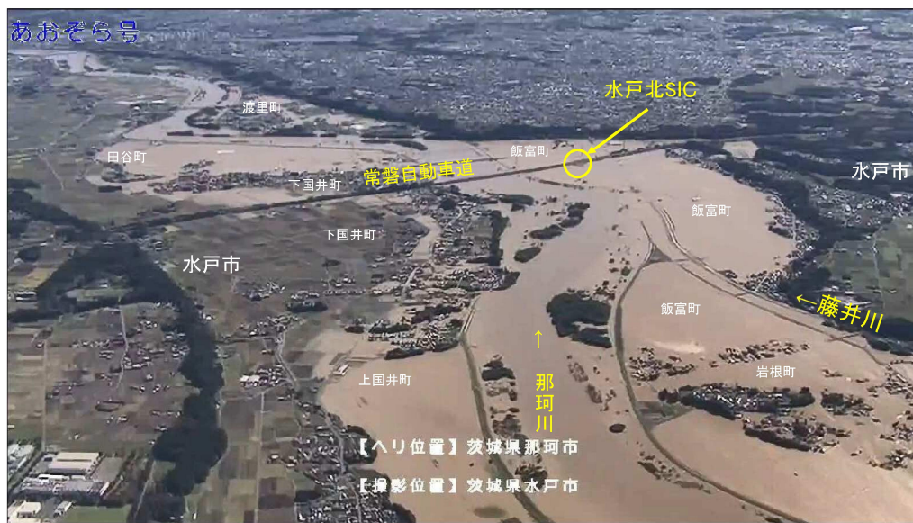
図 4-3 那珂川・藤井川合流付近の状況
