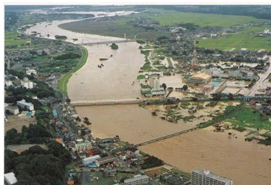
▲平成 10 年洪水那珂川の氾濫（水戸市）
