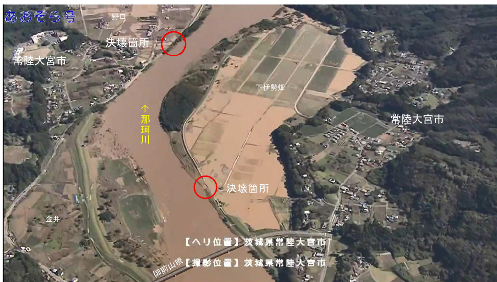
図 4-4 那珂川における堤防決壊箇所
