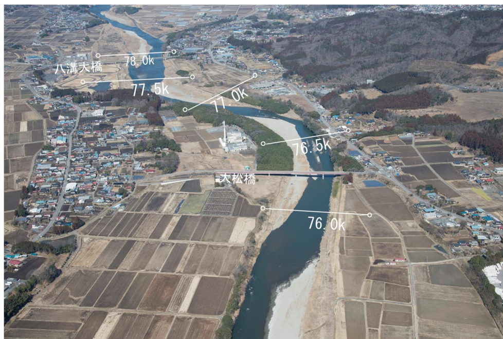
図 8-4 那珂川 大松橋付近（76.0k 付近）
