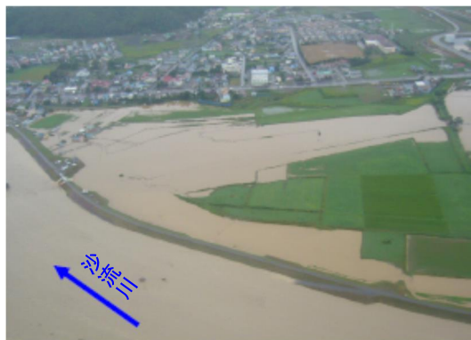
日高町富川地区浸水状況
