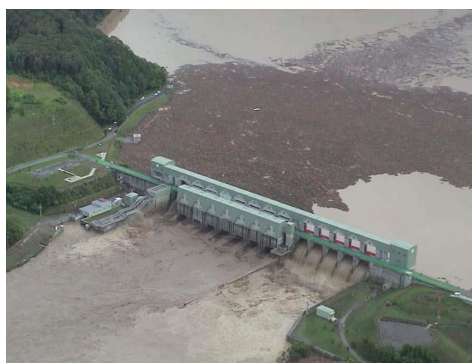
二風谷ダム下流から放流状況
