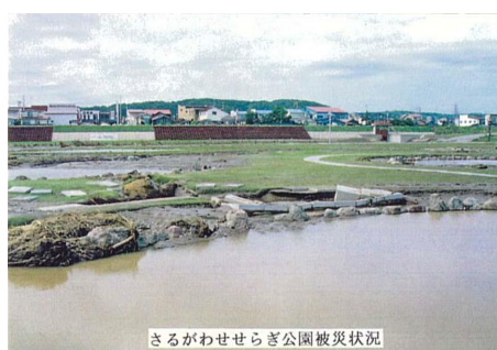
さるがわせせらぎ公園被災状況
