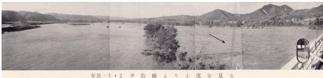
平取橋より上流を見る
