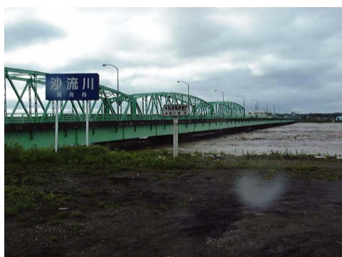
沙流川橋出水状況
