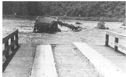
平取大橋の流失・平取町 (昭和 30 年 7 月)
