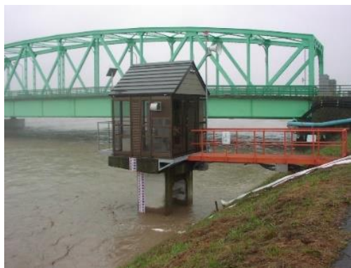
コンカン川樋門出水状況
