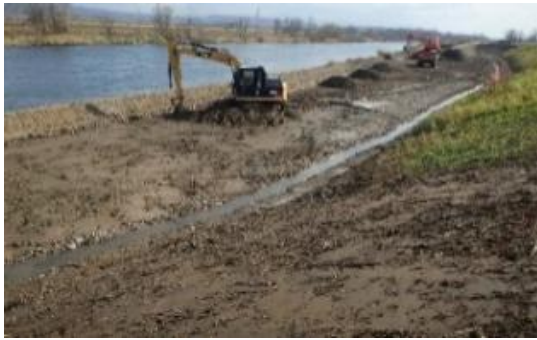
河道掘削状況
