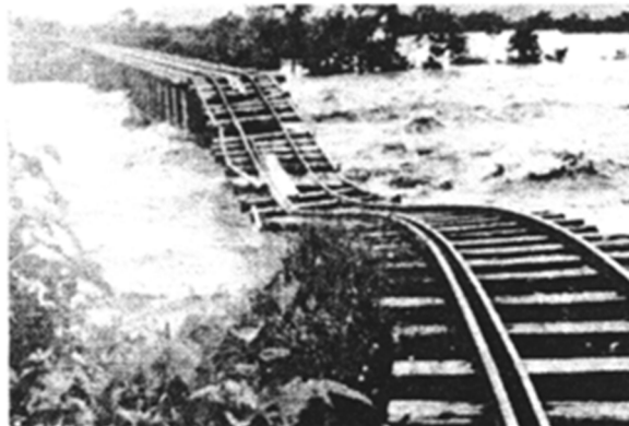
図 4-2 昭和 7 年 8 月洪水（士別軌道天塩川九十九橋の流出）
