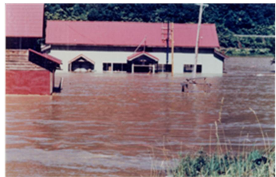
天塩川 音威子府村の浸水状況
