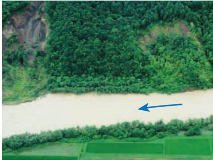
写真 2-1 鷓川本川沿い さかえ 栄地区の山地崩壊状況（平成 15 年洪水後）
