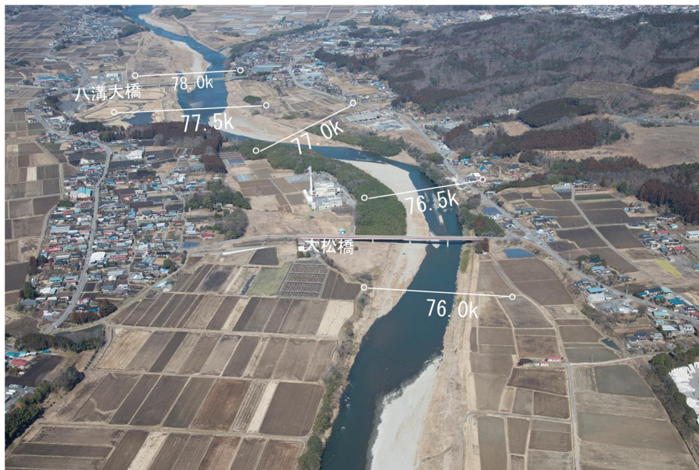
図 4-2 那珂川大松橋付近（76.0k 付近）
