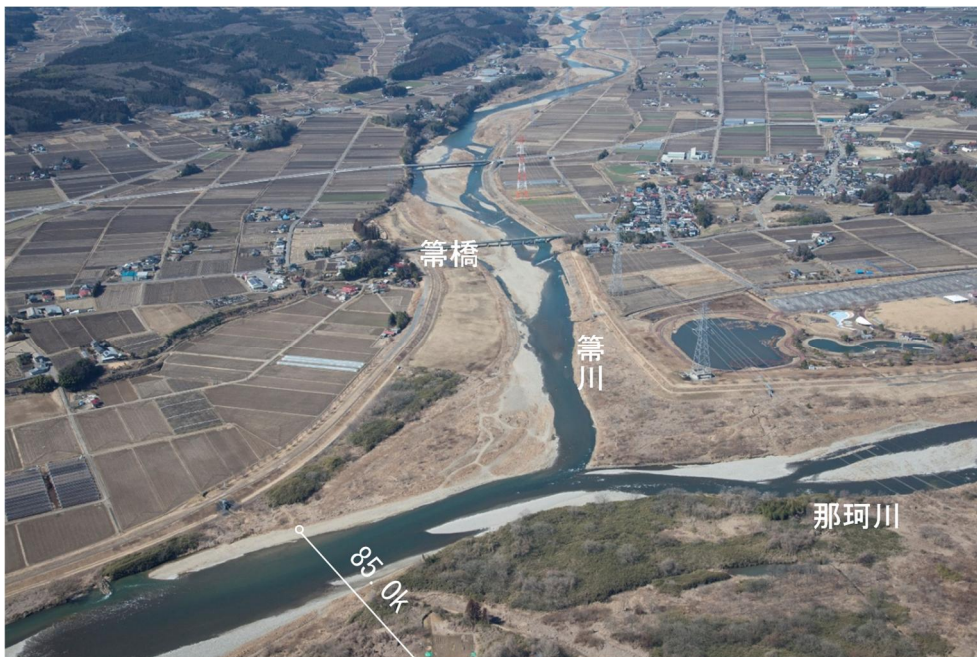
図 4-1 那珂川 箒川合流部付近（85.0k 付近）
