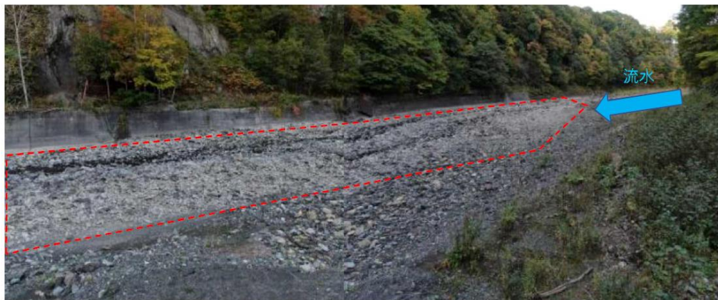
写真 2-5 岩知志ダム下流に還元した土砂が流出した様子
