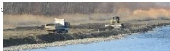
写真 2-12 置土の実施状況
