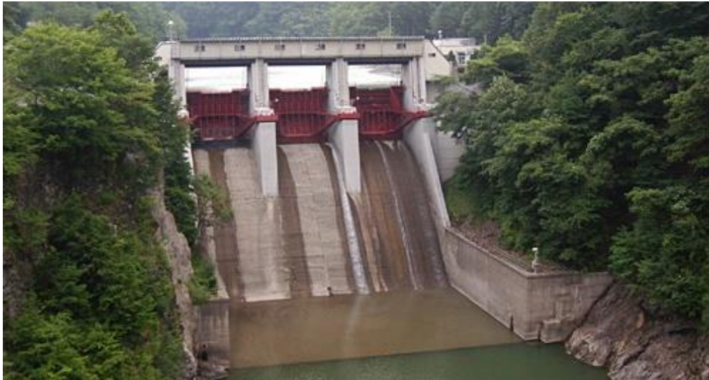
写真 2-4 岩知志ダム近景
